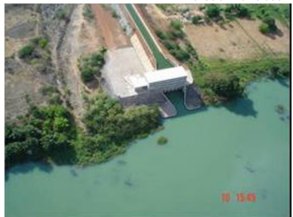
Estação de captação de água no Rio São Francisco
