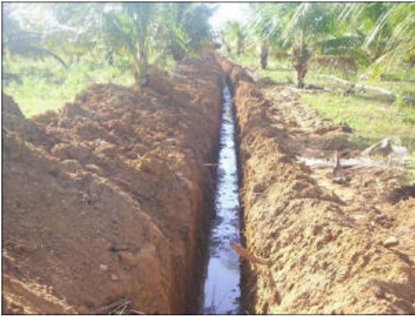
Ao lado, a foto mostra a vala para instalação de dreno subterrâneo.
