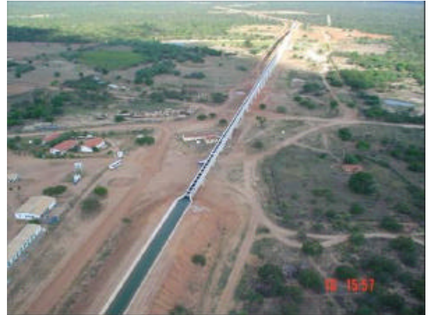
Vista aérea do canal e aqueduto do projeto Pontal
