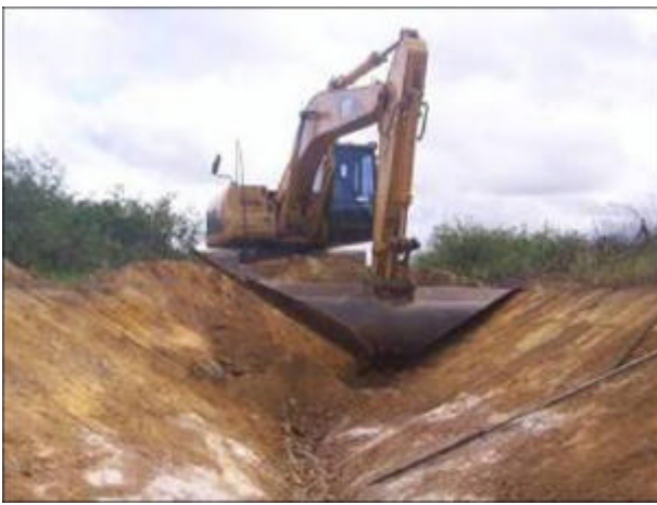
A foto à esquerda ilustra a escavação de dreno coletor superficial.
